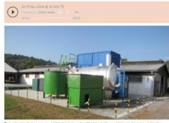
Ta je mikro bioplinška naprava v Jabolju. V 300 litri raztopi in poravnajo za proizvodnjo biometana v 200 litri. Foto: Peter Šušter
