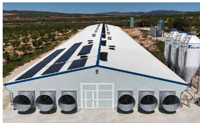
Nave de los hermanos Mislata con energías renovables
